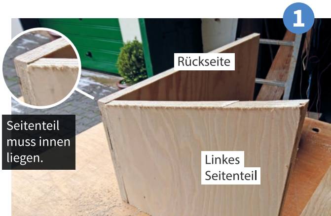
Beide Seitenteile an der Rückseite befestigen
